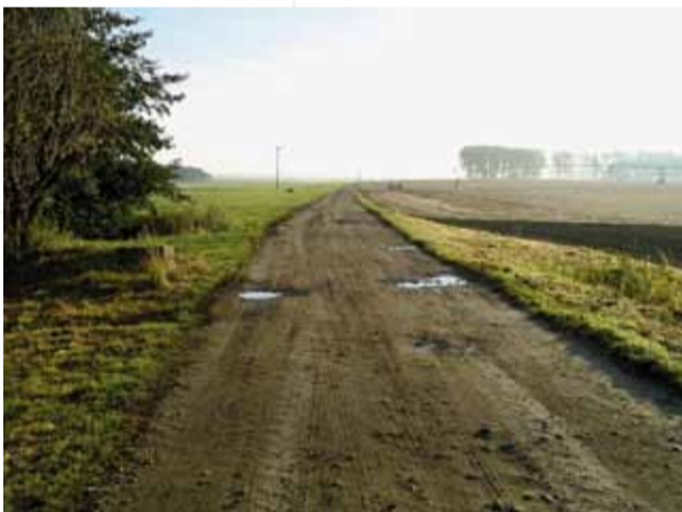
Weg 101 vor dem Ausbau
