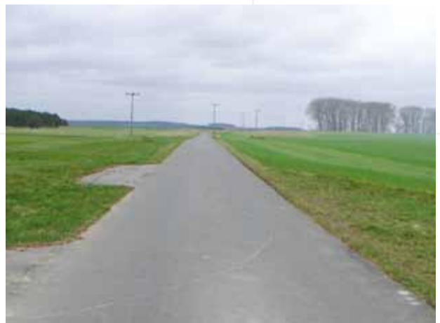
Weg 101 nach dem Ausbau
